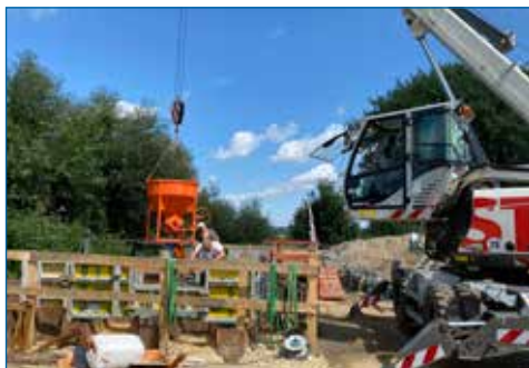
Arbeiten Auflösung Kläranlage
